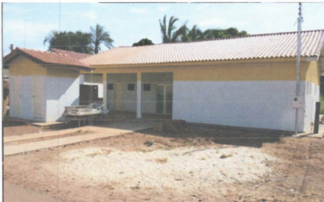
Figura 8 – Reforma e ampliação já dura quase três anos e nada de terminar. O que fazer?
