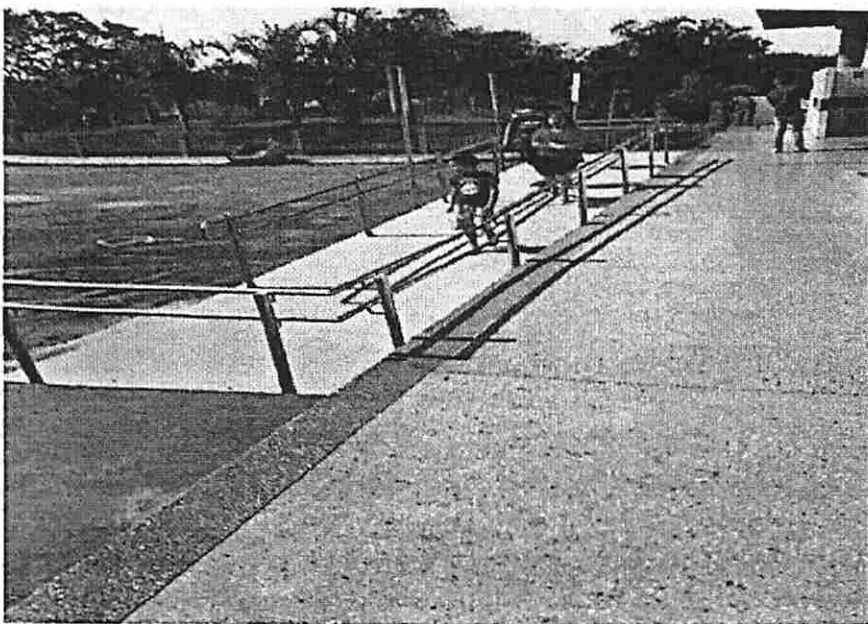
Foto 6 - Vista de rampa de acesso do estacionamento ao saguão do Terminal. Com inclinação conforme as normas técnicas.
