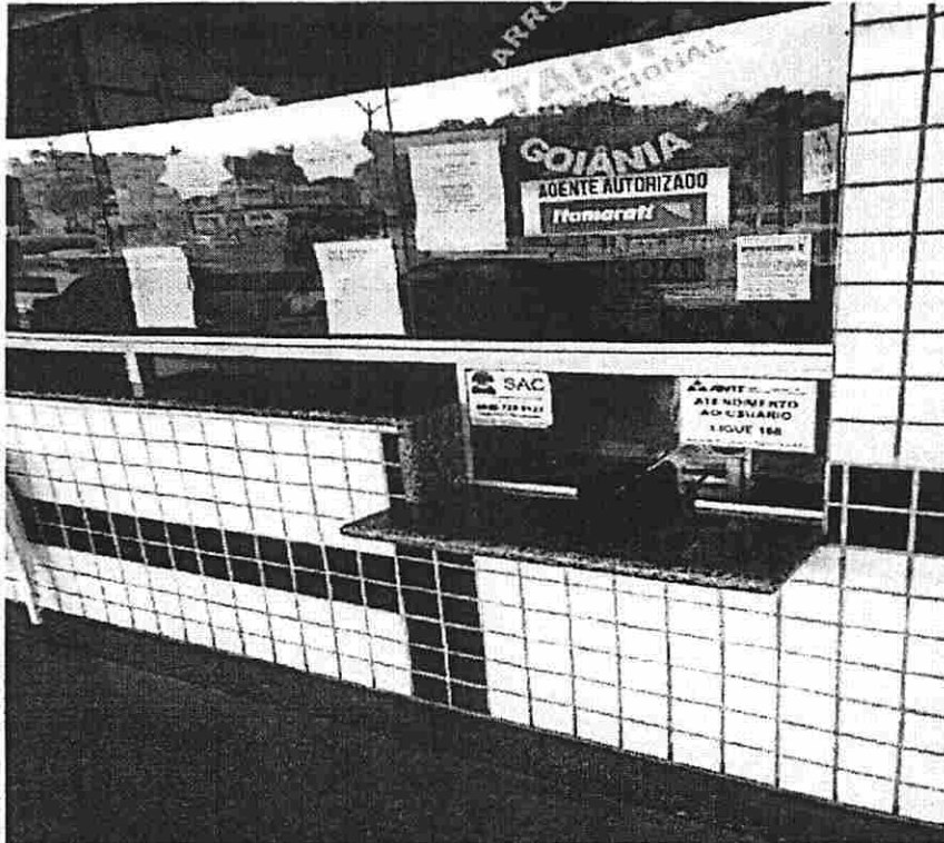
Foto 2 - Vista parcial dos guichês de atendimento ao público mostrando inclusive os rebaixos nos balcões para atendimento aos PCD.
