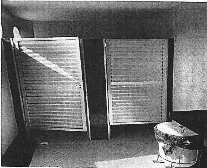
Foto 10 - Vista parcial de sanitário masculino de acesso gratuito mostrando portas em alumínio para os vasos sanitário. Sempre higienizado corretamente. Ver lixeira com saco plástico acondicionado
