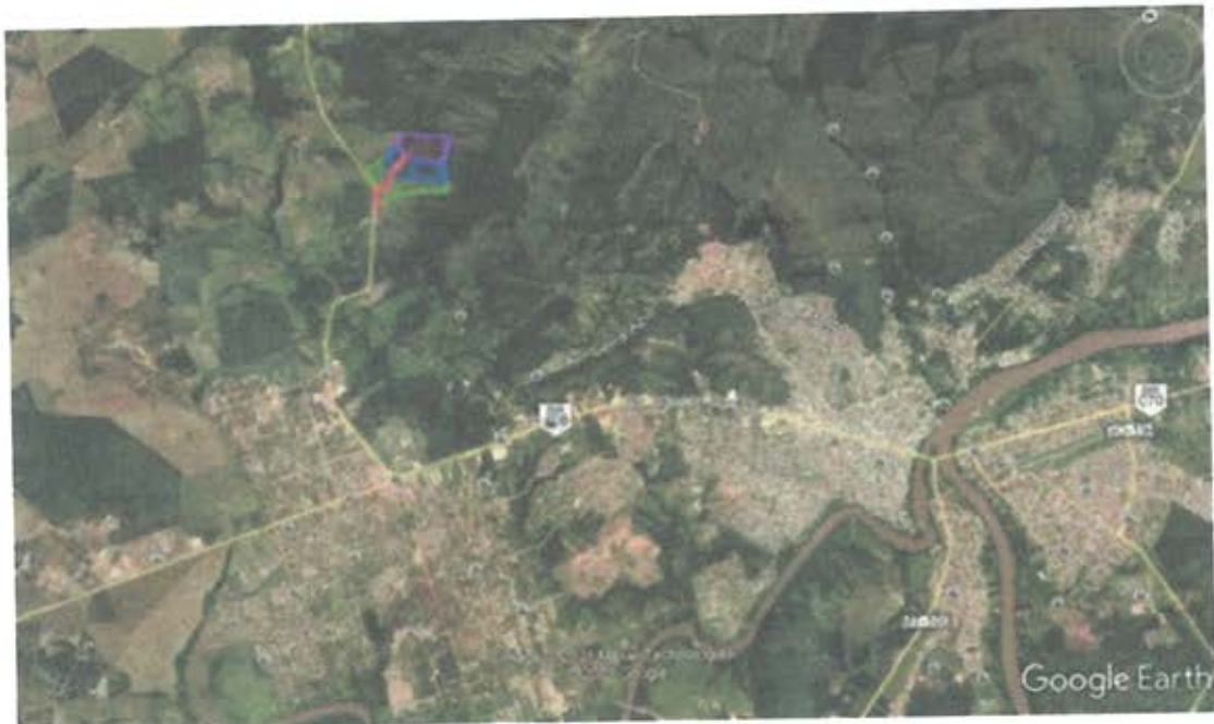
Figura1. Detalhe de cidade de Barra do Garças; no área superior da figura pode-se visualizar a localização relativa da estrada.
