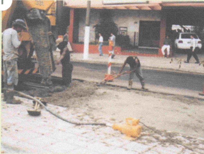
Lançamento e distribuição: Espalhamento manual.
