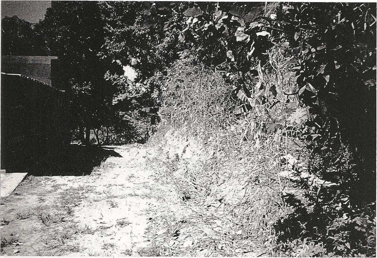
Lateral e parte da Rua
