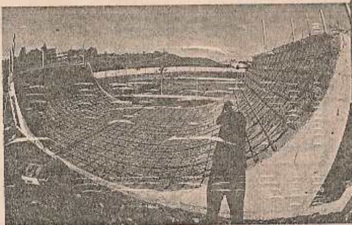
B Cobre-se tudo com concreto armado...
