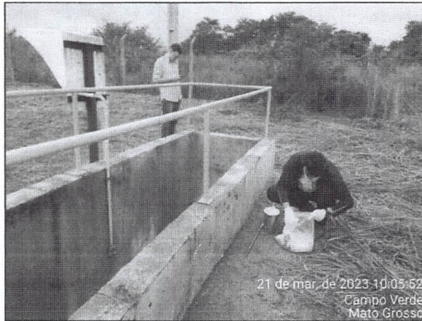
Imagem 02: Detalhe da coleta do esgoto tratado na ETE Rio das Mortes.
