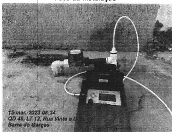
Foto da Instalação
